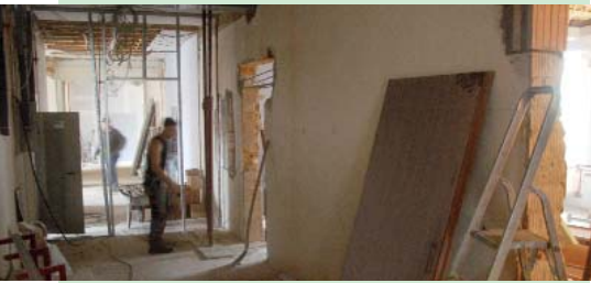
Bauarbeiten für die Chemieräume an der Engelsburg.
